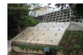
斜面对策工事
