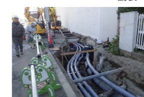
電線共同溝工事
