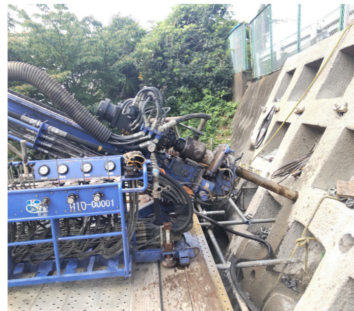
官公庁発注の施工事例
