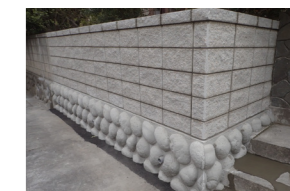
外構整備工事
