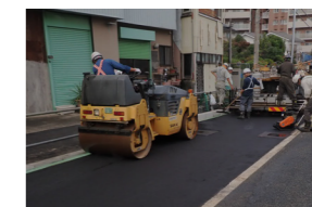
道路改良工事
